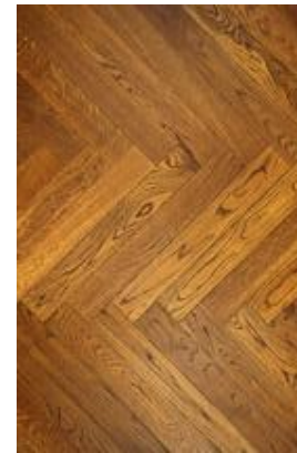
Parkett kalasaba eluruumides ning esikus tamm, pruun lakk harjatud
